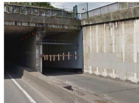
Accès au site depuis le boulevard périphérique
